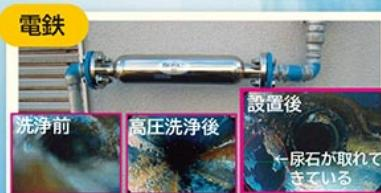
駅舎の給水管に設置。設置前は、下水管の目詰まりから、配管洗浄を年4回実施していましたが設置3か月後に下水管内を内視鏡検査したところ、全体的に高圧洗浄後のきれいな状態を維持していることが確認されトイレのアンモニア臭も軽減され配管洗浄コストが削減できた。
